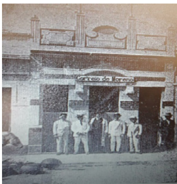
Figura 1. Prédio do Correio de Moreno
