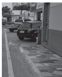
Calçada interrompida por entrada de comércio
