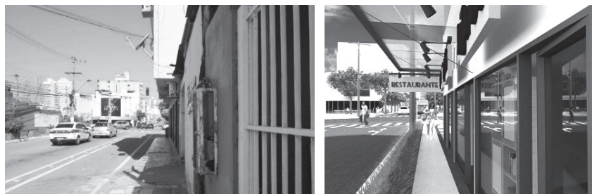
Figura 15: Fotos de calçada e fachada de edifícios do Trecho 1 e representação da proposta de intervenção
