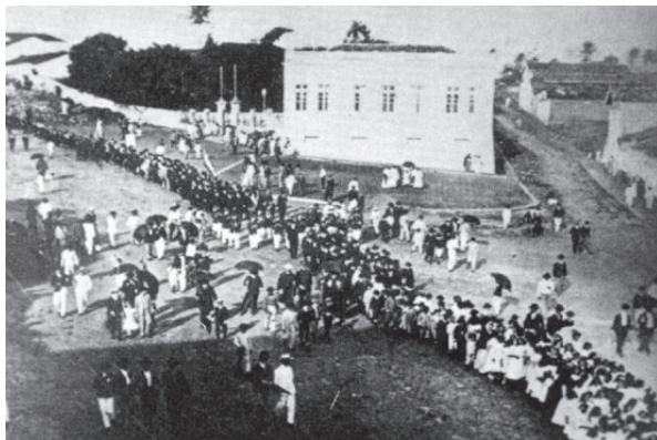
Figura 5: Av. Junqueira Ayres, décadas de 1910-20. A importância da ladeira já calçada e usada em demonstrações cívico-religiosas contrasta com outros acessos à Cidade Alta (à direita)
