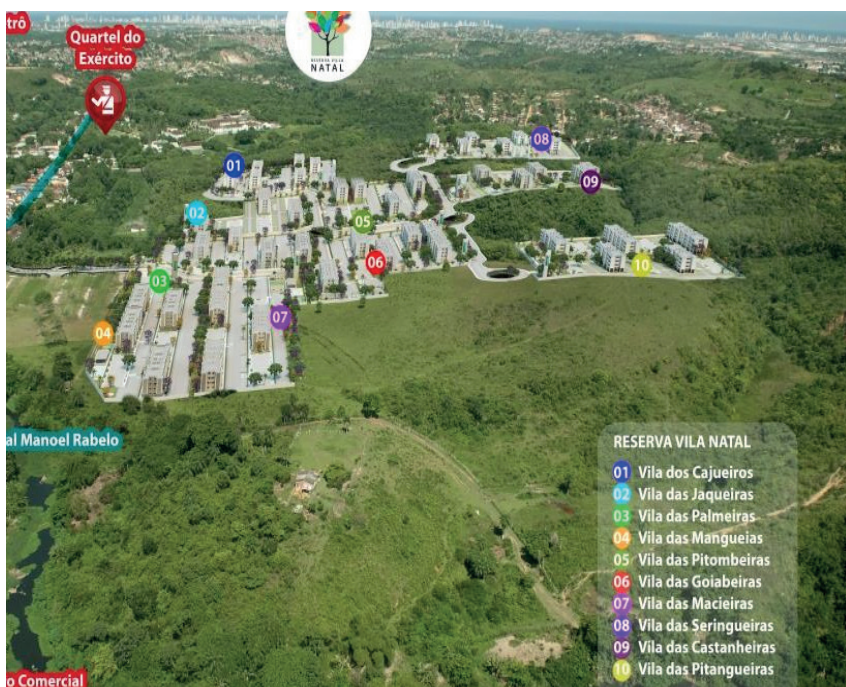
Figura 2. Vista aérea do empreendimento Vila Natal após término das obras
