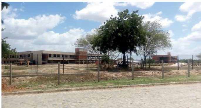
Figura 1. Obras de expansão no campus universitário – UFC/Russas.
