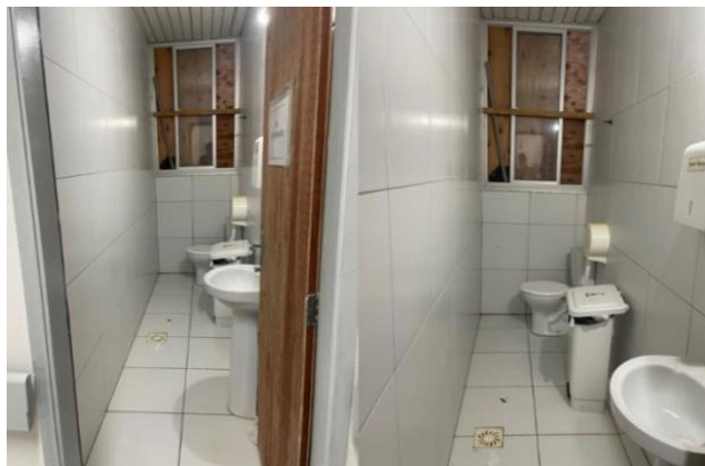
Figura 3. Banheiros do andar fora das enfermarias de clínica médica do HULW/UFPB
