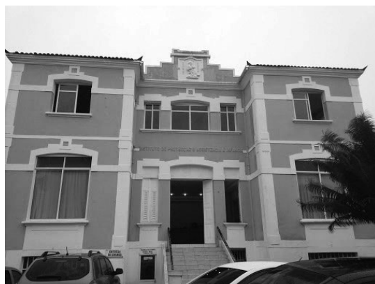
Figura 26 – Hospital São Vicente de Paulo. Ao centro, logo acima da porta principal, ainda está gravado os dizeres “Instituto de Protecção e Assistência a Infancia”.
