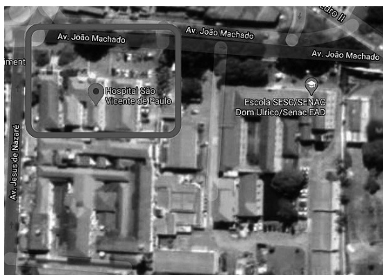
Figura 25 – Vista aérea via Google Maps do Hospital São Vicente de Paulo (anterior Instituto de Assistência e Proteção à Infância) e do Orfanato Dom Ulrico.
