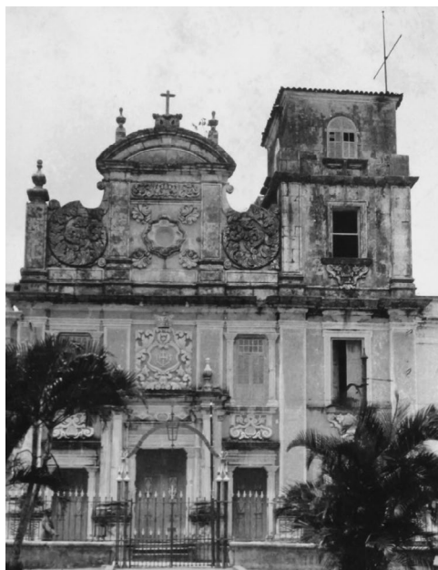
Figura 3 – Fachada da Igreja de Nossa Senhora da Conceição dos Militares, antes de ser demolida em 1929, localizada atualmente na R. Duque de Caxias, 622, Centro (João Pessoa).
